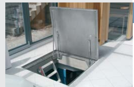
Exemples : couvercles du regard montés
