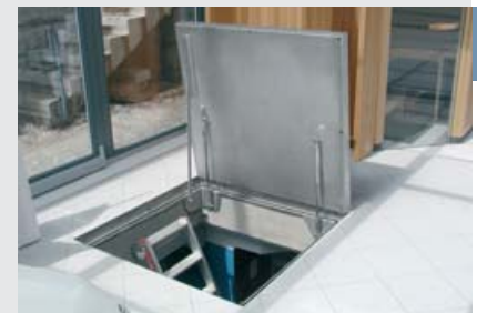
Παραδείγματα από τοποθετημένα καλύμματα φρεατίων
