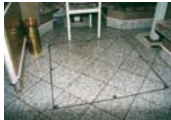
BV-luukku kahvilan lattian asennettuna
