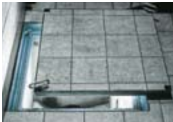
BV-luukku avattuna nostokahvat paikalleen kierrettynä
