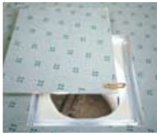
BV-alumiini luukku avattuna tekstiilimatolla päällystetyssä lattiasa
